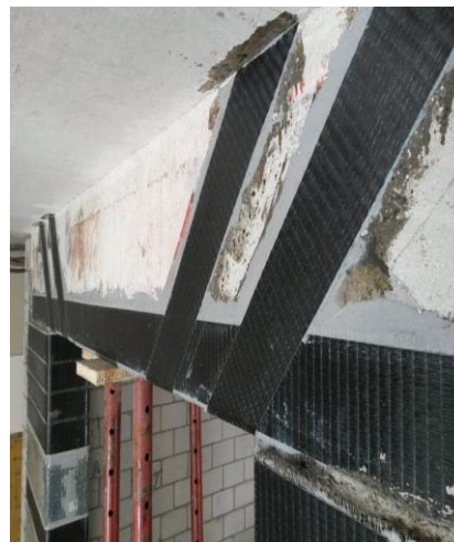
наклеивание углепластиков лент
