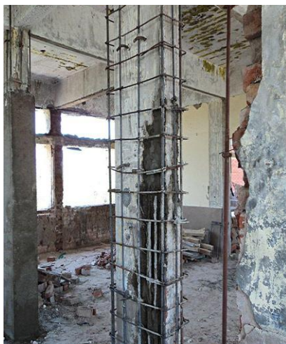
обетонирование
