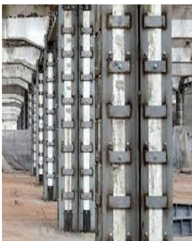
внешнее армирование металлопрокатными профилями
